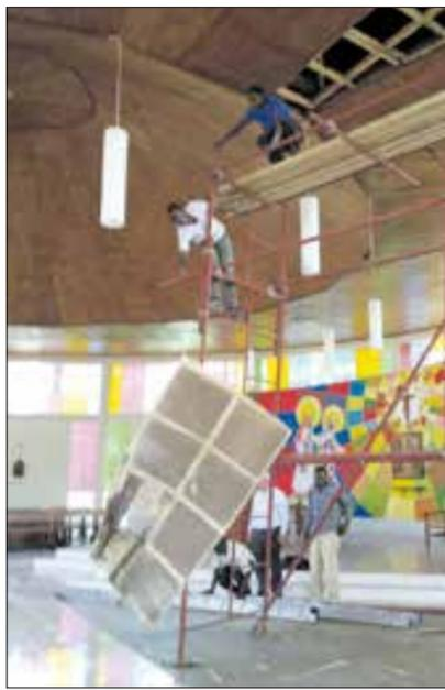
Starker Monsunregen ist unter die Dachhaut gelangt und hat die Statik der 16 Holzbinderkonstruktion negativ beeinflusst.
